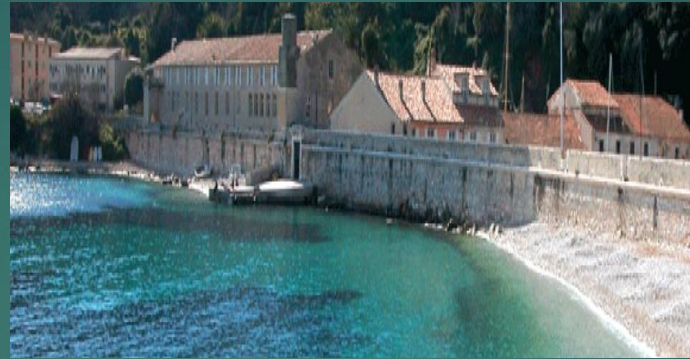
Le laboratoire russe dans l'ancien hôpital des galériens
